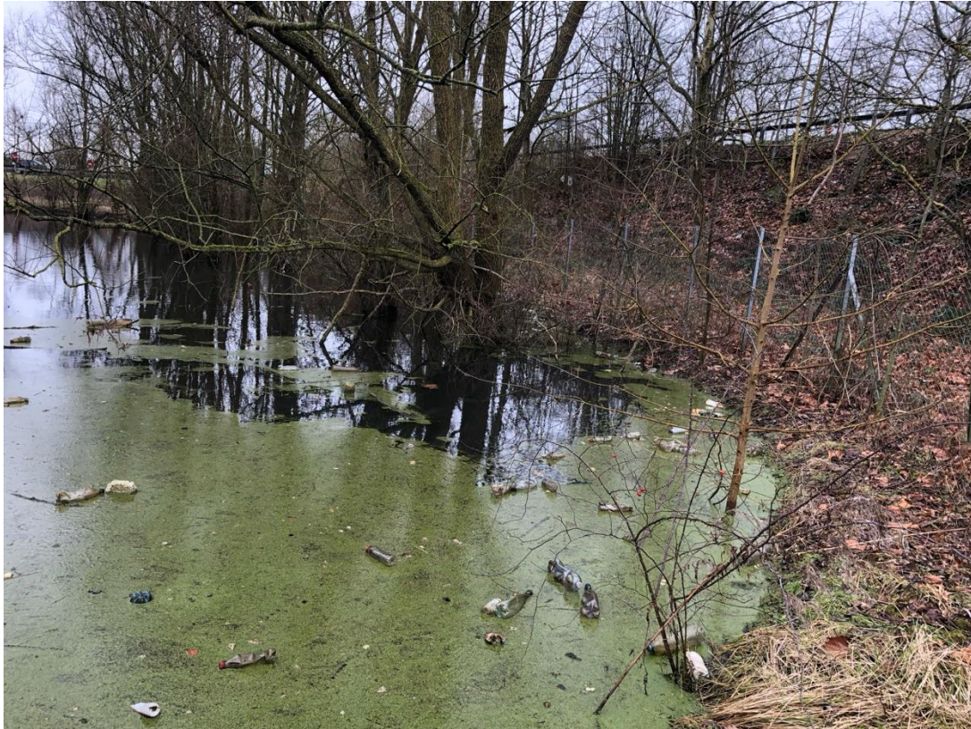
Bassin d'assainissement PR 34+400)
