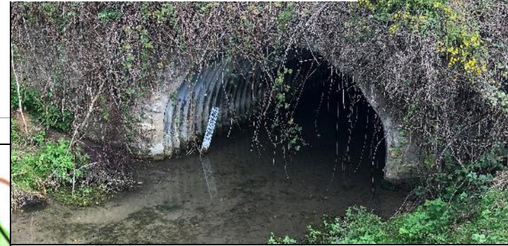
Tête amont OH sous chemin d'exploitation
